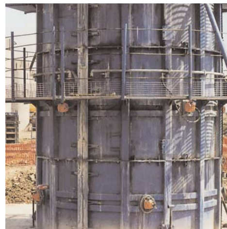
Tubería de Concreto
